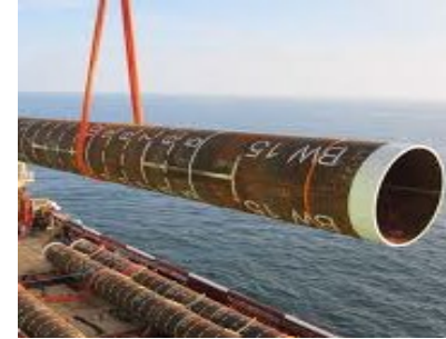
Pile anchors
