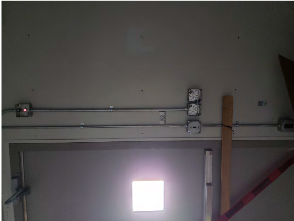
CM Module Raceway
