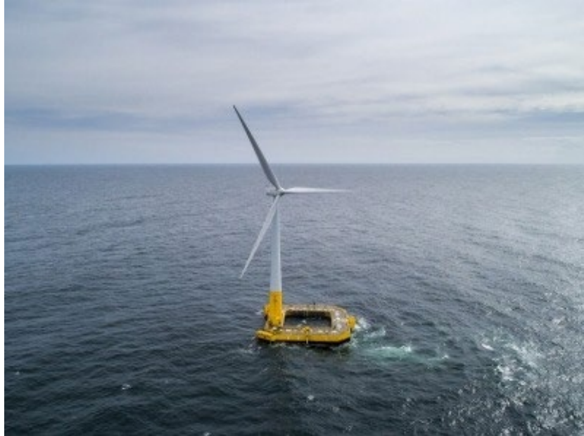
Figure A-4: Floatgen Barge Concept
