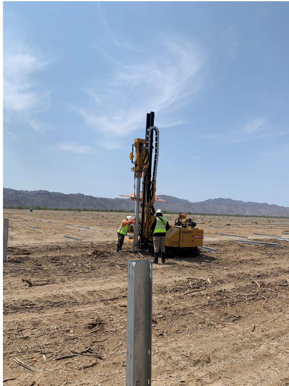
Proyecto Drew Solar - Hincado de pilotes en el suelo
