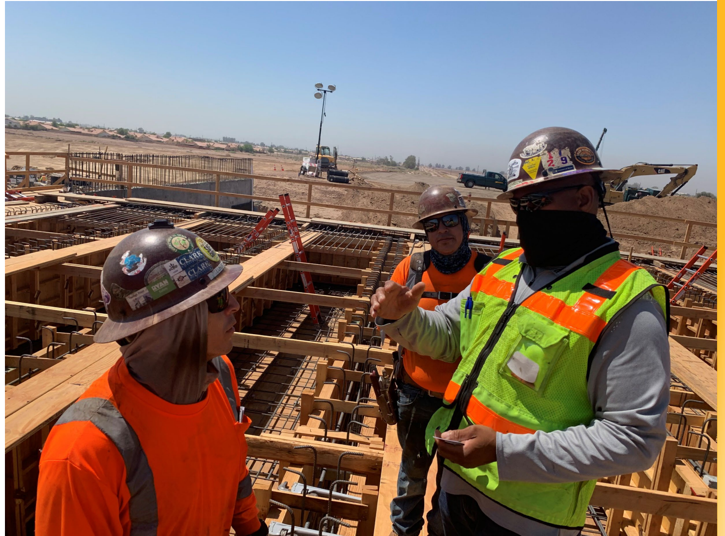
Refuerzo de un nuevo puente sobre la autopista 8
