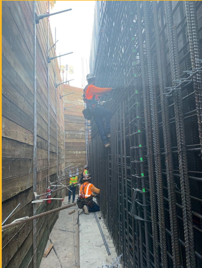
Colocación de barras de refuerzo en el puerto de entrada de Calexico
