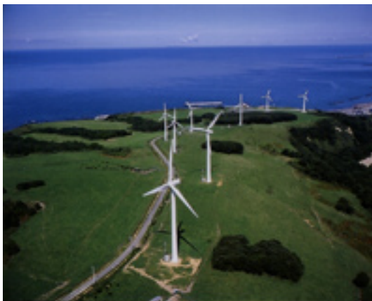
【図2】 丘陵の尾根上の牧草地に建つ風車。夏には草丈が一気に伸びるため、その時期の調査や評価の方法は工夫しなければならない。(礼受風力発電所、留萌風力発電所 / 北海道)
