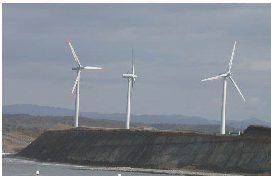
【図12】海岸段丘に建つ風車。設定する調査範囲のうち50%近くは崖下となるため、評価には補正が必要となる。この施設では今までに、通行人などによって数例のオジロワシの衝突死が確認されている。
