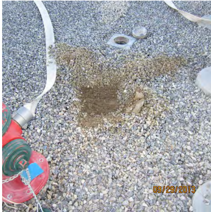
U3 Raw Water Spill
