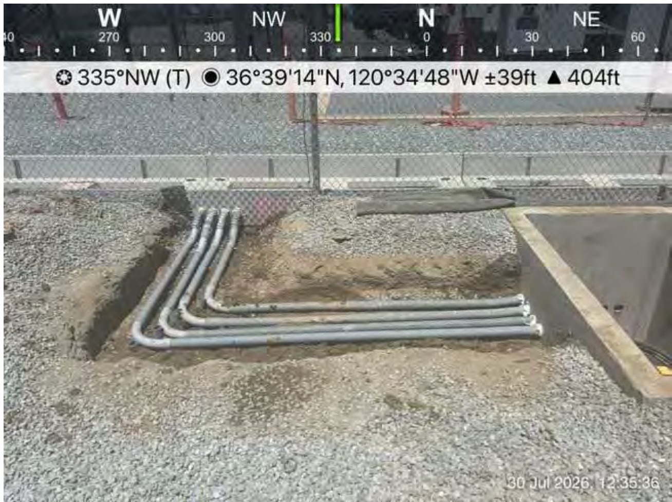
Conduit trench installation.
