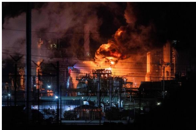
Figura 14. Incendio en la refinería Chevron a las afueras de Los Ángeles 97
