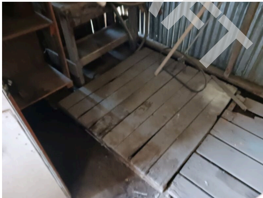
28. Storage room interior.
