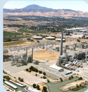
BESS de Marsh Landing Condado de Contra Costa
