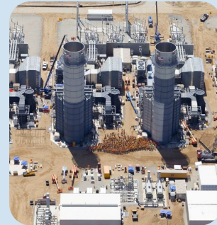
Stanton Energy Centro de Fiabilidad BESS Condado de Orange
