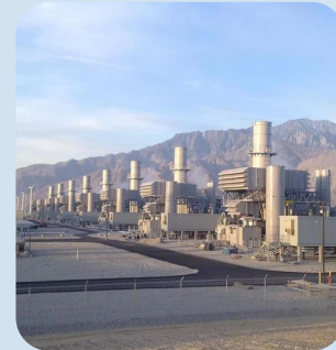
Centro de Energía Sentinel BESS Condado de Riverside
