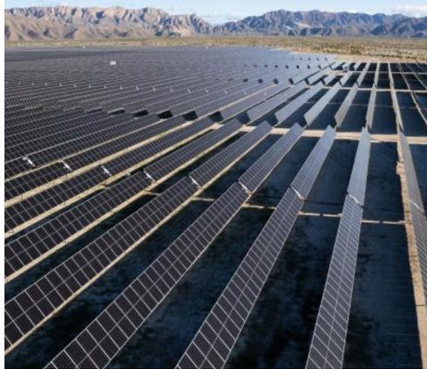
Las necesidades operativas en el lugar incluyen el monitoreo y la optimización de la energía generada por los paneles solares y la interconexión con las líneas de transmisión, la operación del Sistema de Control de Supervisión y Adquisición de Datos, la solución de problemas de las líneas de colectores y la reparación de cables dañados, y la realización de actividades de lavado de paneles periódicamente durante todo el año.
